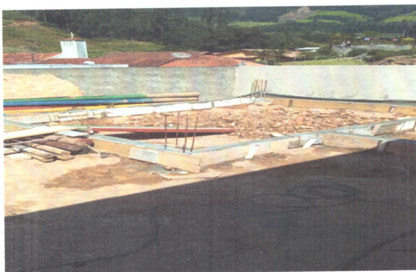
CONCRETAGEM DA FUNDAÇÃO DA SALA DO MATERNAL E BANHEIRO
