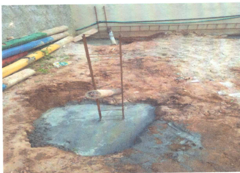
ESCAVAÇÃO E ARMAÇÃO DE AÇO DA FUNDAÇÃO DA SALA DO MATERNAL E BANHEIRO
