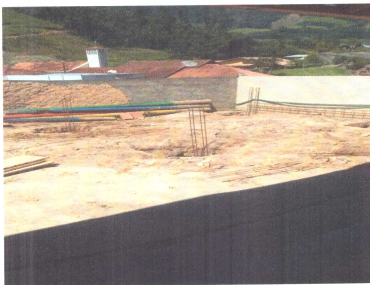
ESCAVAÇÃO E ARMAÇÃO DE AÇO DA FUNDAÇÃO DA SALA DO MATERNAL E BANHEIRO
